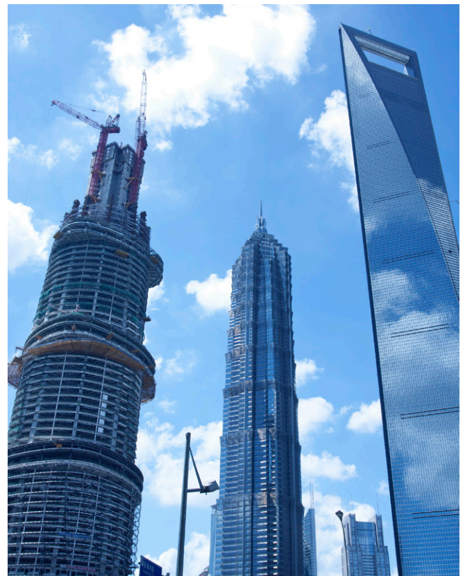
Der Shanghai Tower, hier links ein Bild von der Baustelle, wird bei seiner Fertigstellung im Jahr 2014 mit 662 Metern das zweithöchste Gebäude der Welt sein.
